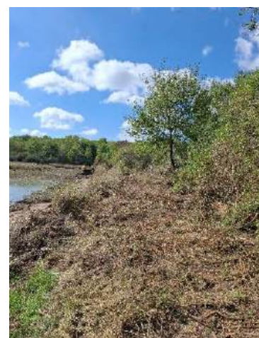
Figure 15 : digue de la Grande mare de la Sous
